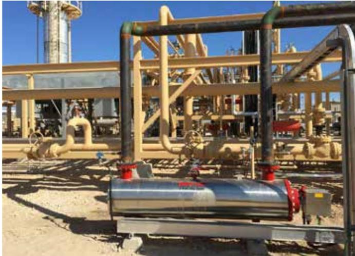
Los sistemas de combustión **Wayler Serie TAP**, son ideales para aplicar en la industria **Oil & Gas**, especialmente en los precalentadores para petróleo o gas, que se instalan en campo.
