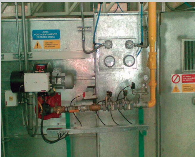
Sistema CVHI aplicado a secadero de industria farmacéutica.
