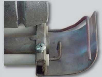
Piloto con electrodos desmontables sin sacar quemador de la cámara
